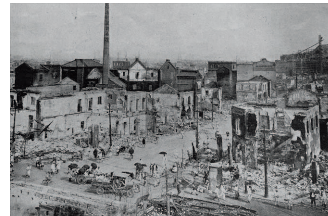
関東大震災発生後の銀座(1923年)
