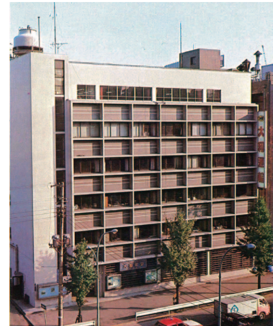
竣工から数年後の新本社ビル(現在この場所はスワンカフェ銀座店)
