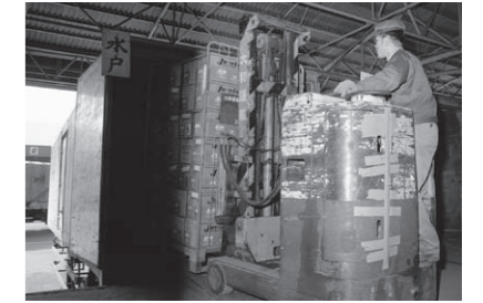
雑貨混載のボックスパレットでの作業(ボックスパレットにはまだ車輪が付いていない)
