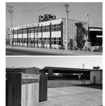
名古屋支店(1972年12月竣工) (上・愛知県小牧市に竣工した名古屋支店の外観、下・東京支店に次ぐ規模で開設した名古屋支店の別名は小牧トラックターミナル)
