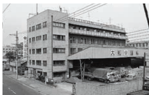
3 大阪市西区川口町に新設した大阪支店(1961年12月)
