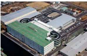
18 2007年に完成したヤマト運輸神奈川 物流ターミナル全景。当時、ヤマトグル ープ最大規模の本格的な物流ターミナ ル第1号で、神奈川ベースとヤマトロジ スティクスが入った物流棟が併設された
