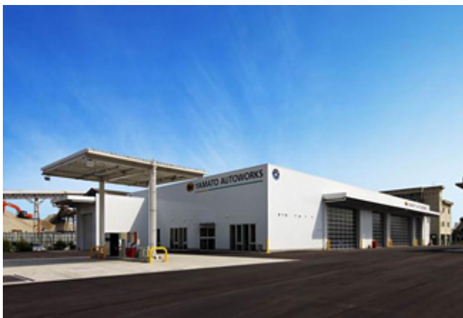
2013年4月、中部地区で4店目となる「スーパーワークス名古屋工場」が竣工
