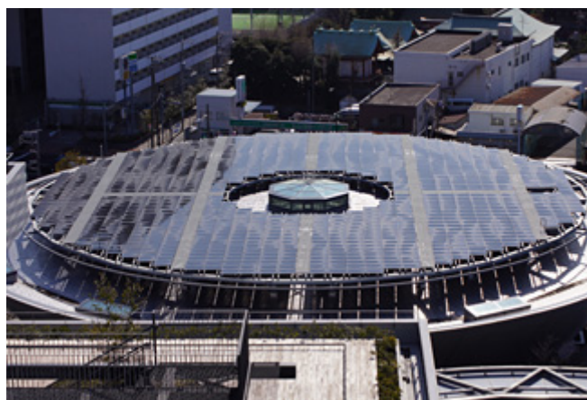
ヤマトフォーラム屋上の太陽光パネル
