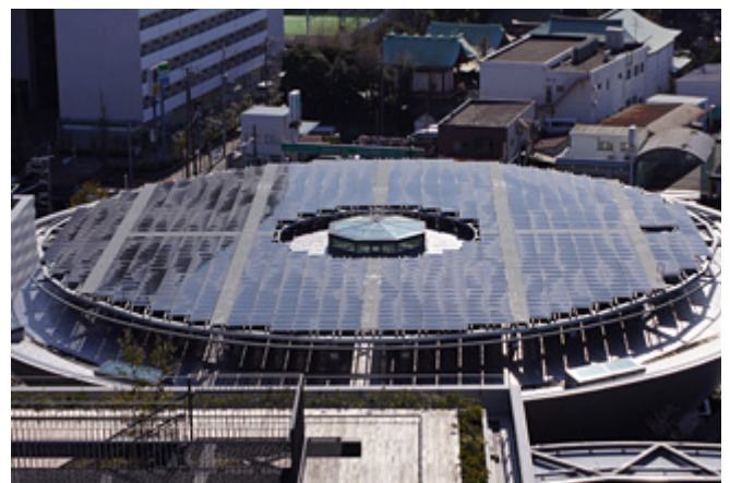
構内スポーツ施設屋上に太陽光パネルを設置
