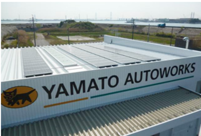
太陽光発電システム(スーパーワークス名古屋工場)
