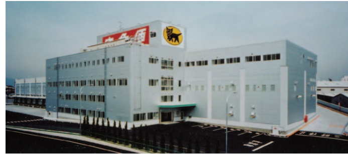
新たに建設した北大阪主管支店
