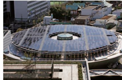
太陽光発電設備
