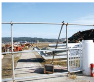
津波により流失した旧施設
