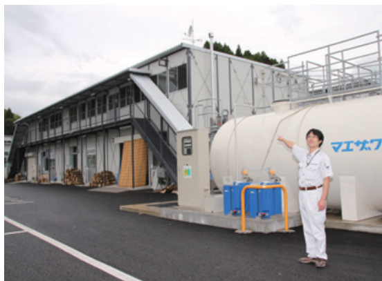
50t／日の能力を持つ排水処理施設も建設
