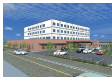
公立小野町地方総合病院企業団 ●鉄骨造り（耐震構造Ⅱ類）、地上4階＋塔屋階 ●駐車台数：一般駐車場80台、夜間・救急用駐車場12台
