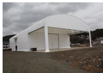
（仮設ワカメ作業所）
